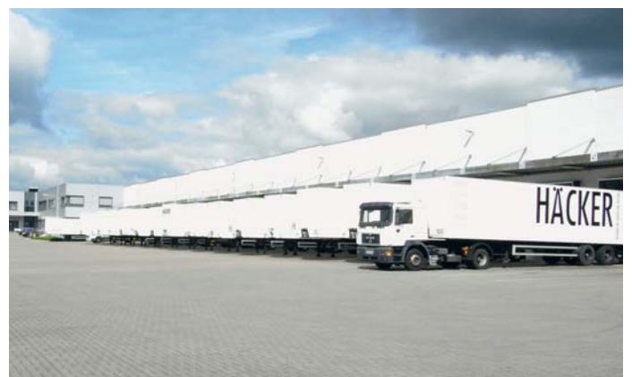
Ansicht Hof mit Laderampen
